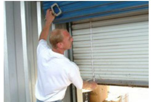
5. Amener la porte dans une position fermée d'environ  $\frac{3}{4}$  de façon à ce que le haut du rideau soit enroulé sur le haut de l'ensemble de l'axe et soit accessible. Placer une pince sur les guides droit et gauche, sous la barre inférieure, pour maintenir le rideau en place.
